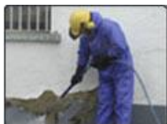
Risanamento di facciate, rimozione di intonaci
